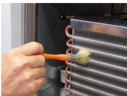
**¡ADVERTENCIA!: Nunca utilice agua para llevar a cabo la limpieza del condensador ya que podrían dañarse los componentes eléctricos cercanos.**
